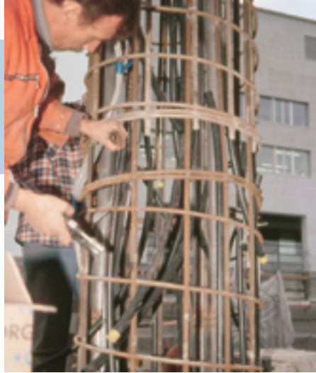
Inserimento delle sonde geotermiche nei pali di fondazione (fonte: documentazione tecnica Suisse Energie).
