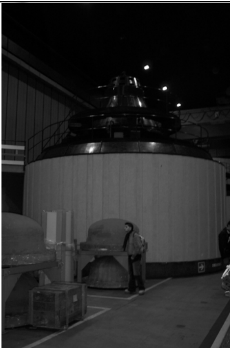
Alternatore da 140 MVA
